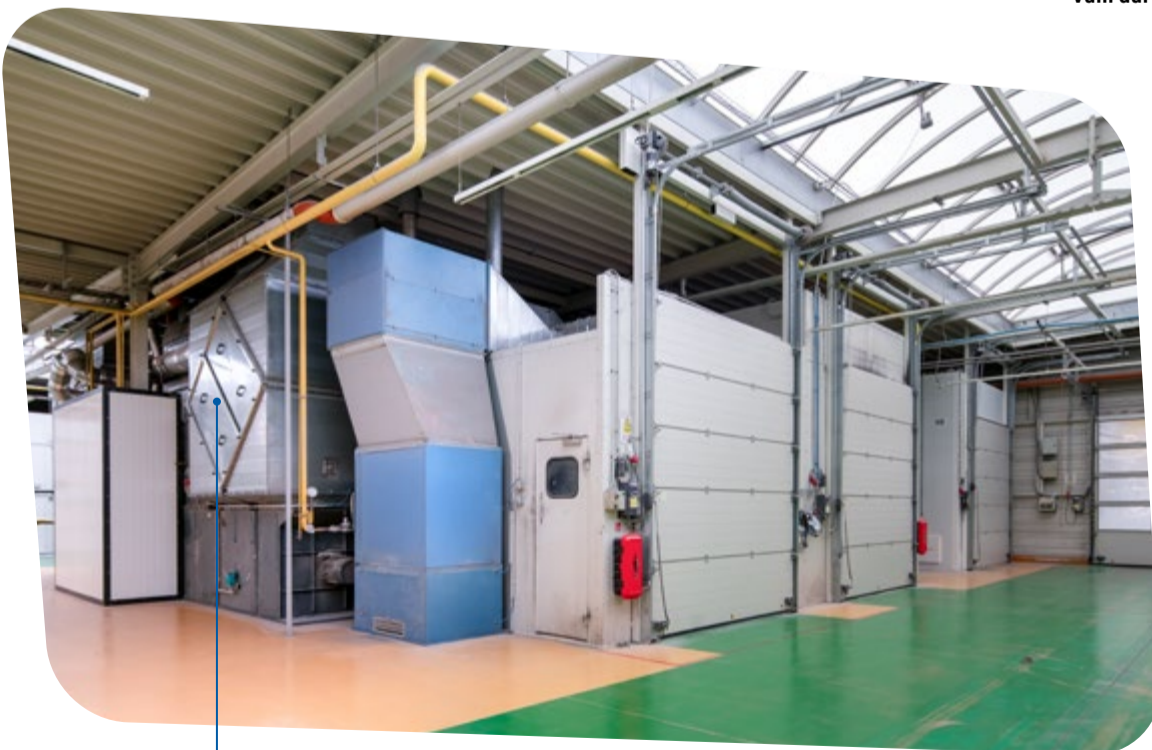
Na dva dříve instalované průjezdné lakovací boxy LUTRO byla rekuperační jednotka instalována dodatečně. Podmínkou použití rekuperace tedy není pouze na nové lakovací boxy.
